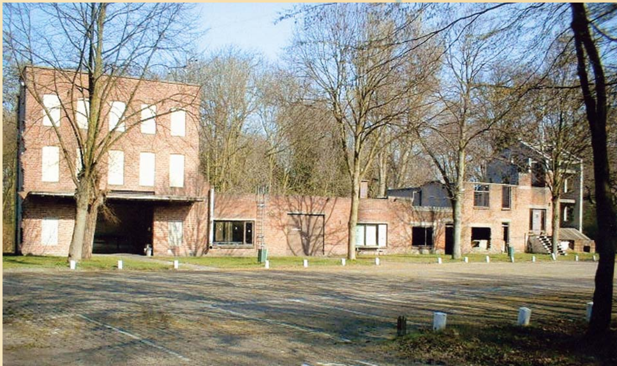
Unieke oefenruïne op het voormalige BB opleidings- en commandocomplex Overvoorde te Rijswijk
